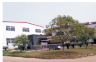
改造升级后的污水处理站
